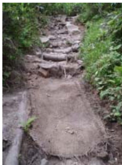
写真 - 6 光ケーブル沿いの道のムシロとペグ
