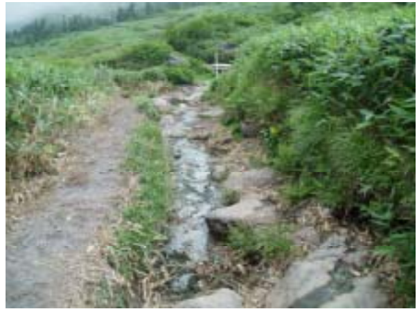
写真 - 1 南龍ヶ馬場の汚水漏出状況
