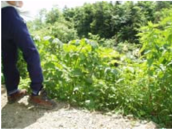
写真 - 7 CCTV取付道の植生回復状況 (施工後4年目; 06年8月撮影)
